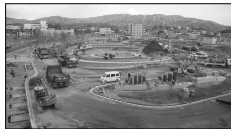
写真-5 工事中の東駅前広場 (H24. 1. 25)
