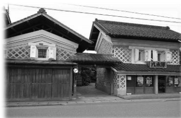
気仙大工が築いた明治期以来の古い 商家が並ぶ重厚な町並み
