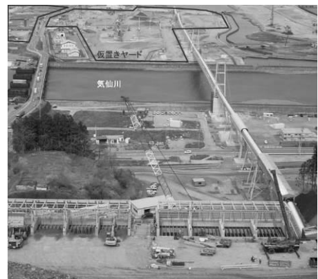
ベルトコンベア施設全景(出典:清水JV HP)
