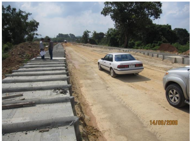
ヤラー地区都計道路建設
