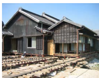
(移転(曳家)工事)
