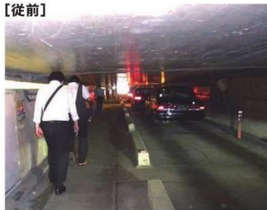
高輪橋架道橋(通称:お化けトンネル)
