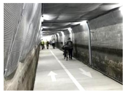
隣接する排水渠を活用した歩行者動線切替
